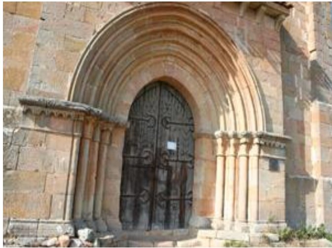
La topografía del terreno obligó a que la portada, de 4 arquivoltas, se abriera al Norte.
