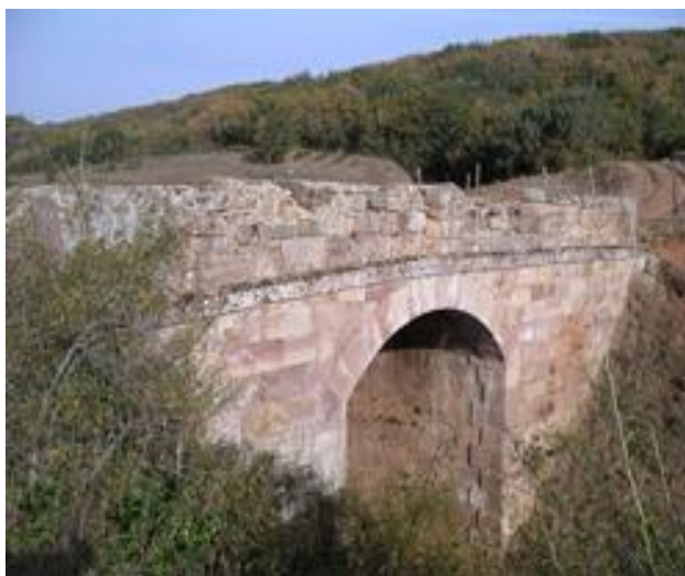
Puente Contadero sobre la antigua vía férrea.
